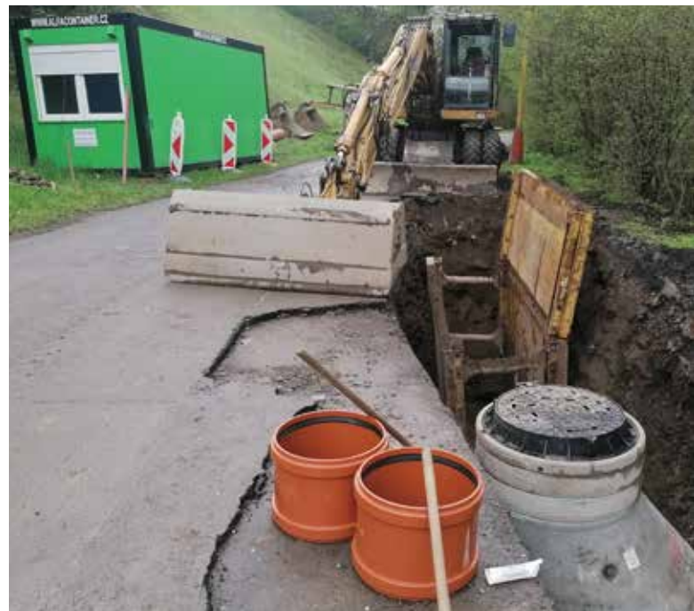
Oprava kanalizace Hrachovec
