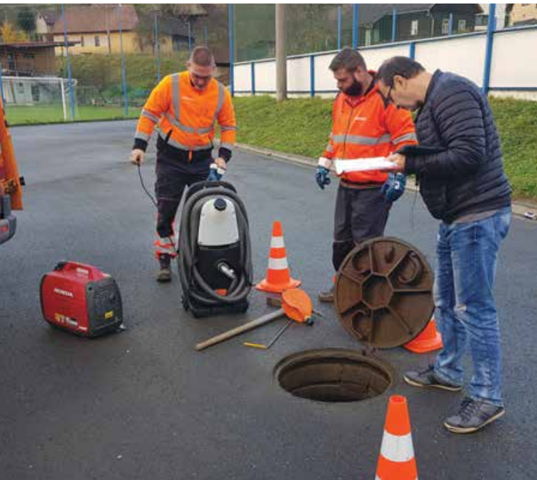
Kontrola napojení srážkových vod
