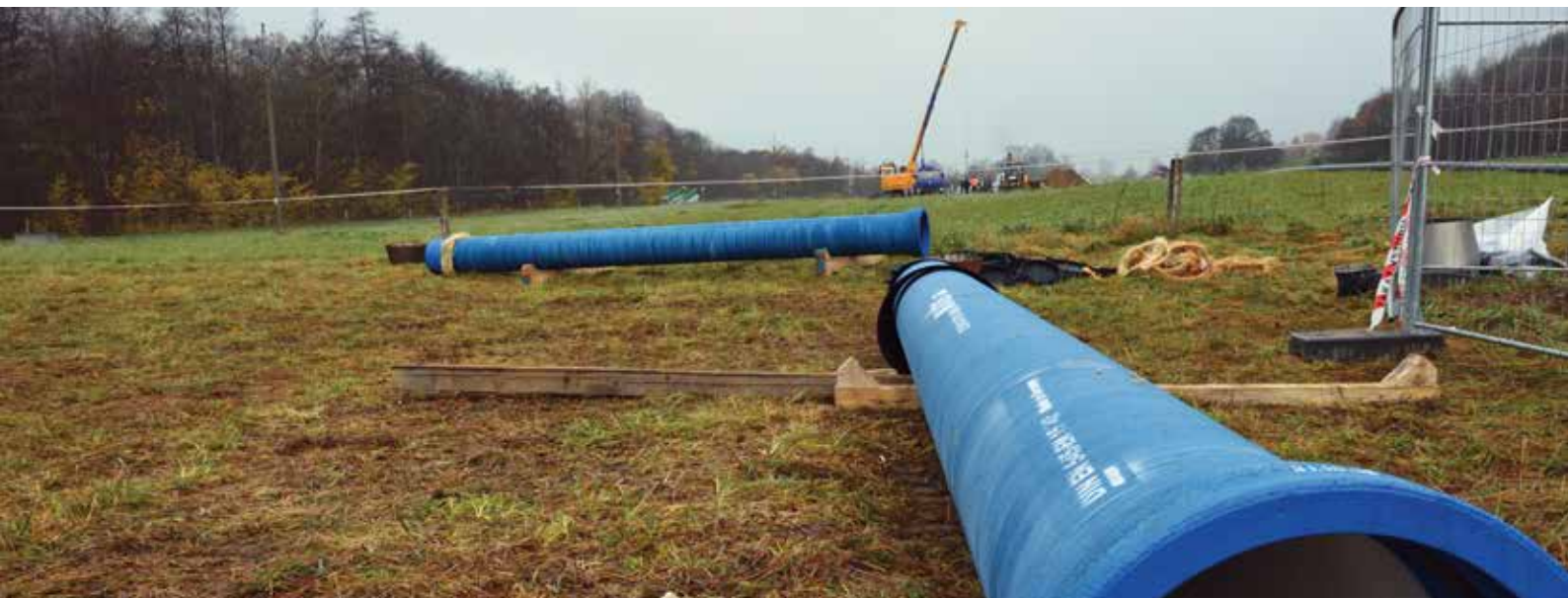
Pokračování výměny skupinového přivaděče Ústí - Lužná
