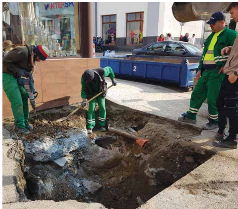
Oprava kanalizace v Rožnově p. R. - u kostela
