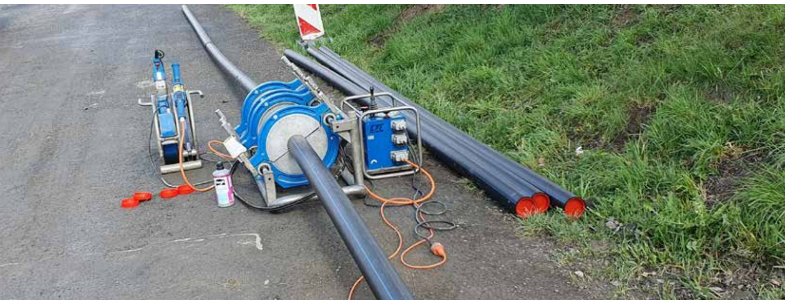
Oprava vodovodu Bynina
