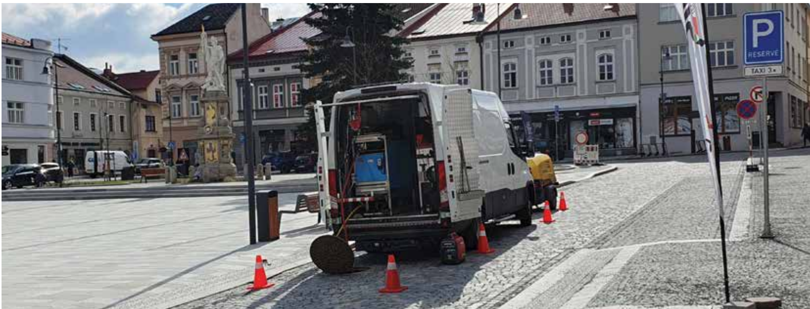
Vložkování kanalizace náměstí Valašské Meziříčí
