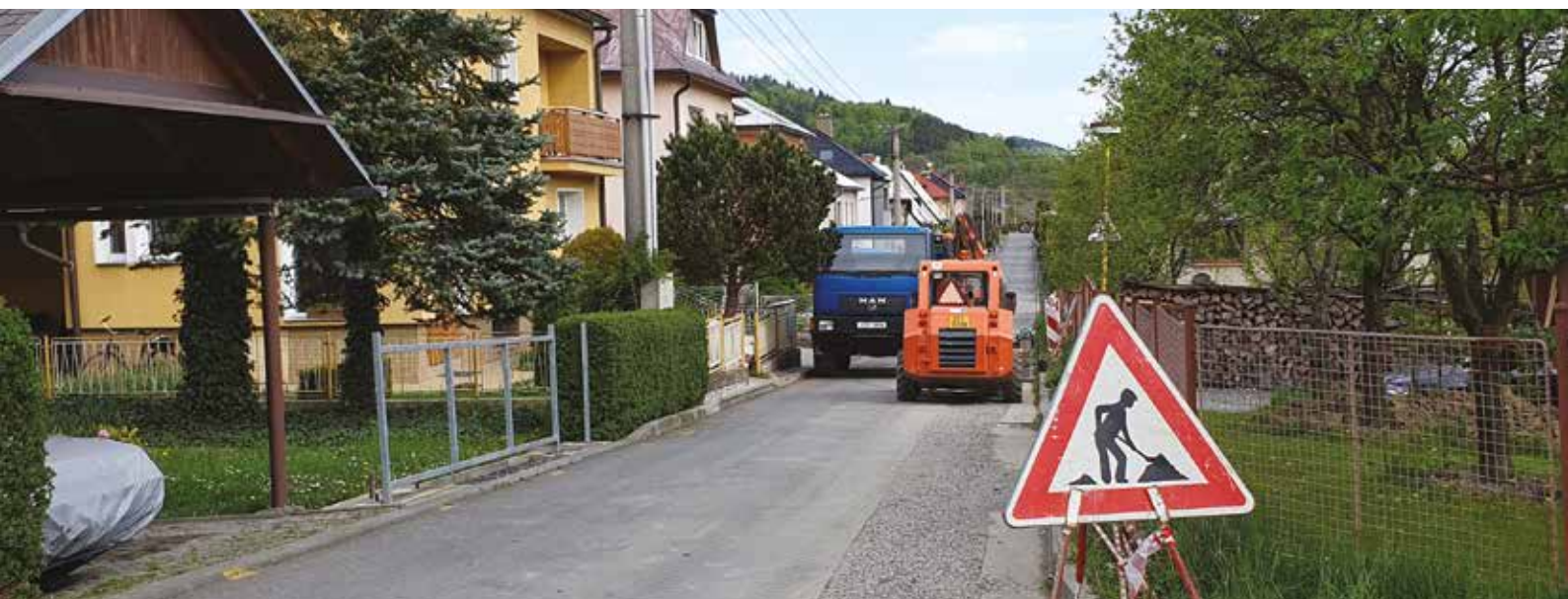
Oprava vodovodu v obci Valašská Polanka
