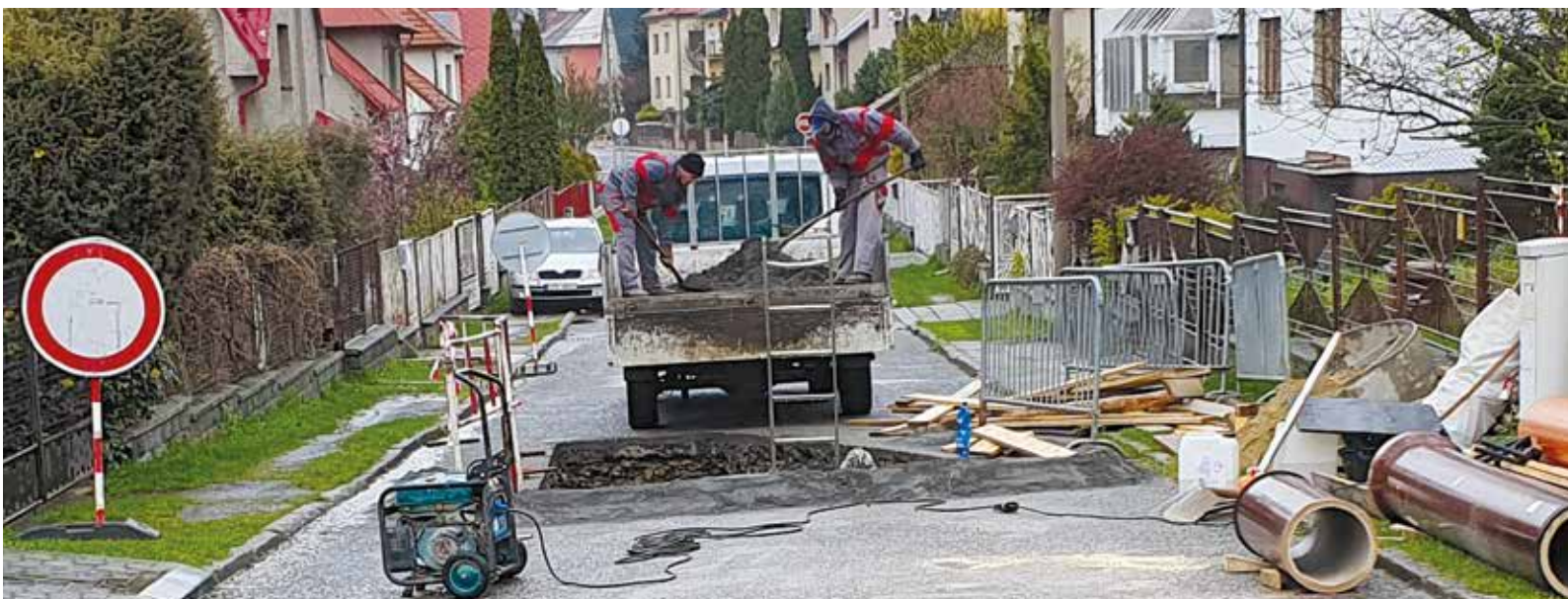
Oprava kanalizace Val. Meziříčí ul. Blahoslavova
